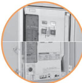
→ Obod vrata omogućava IP20 stepen zaštite. Za IP31 potrebno je tražiti vrata prekidača sa zaptivkom. IP pokrivač omogućuje stepen zaštite IP55 (IEC 60529). IP pokrivač se može postaviti čak i kada je prekidač i položaju IZOLOVAN.
