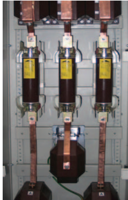
Veživanje u unutrašnjem sklopnom (uklopnom) uređaju, primjer:
