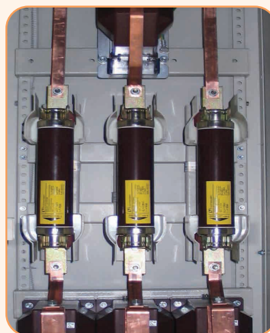
Położenie wkładek topikowych zamontowanych na zewnątrz.*
